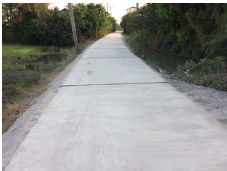
ก่อสร้างถนนคอนกรีตเสริมเหล็ก หมู่ที่ ๓,๔,๕,๖
