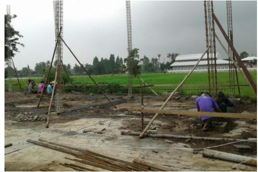
ก่อสร้างอาคารและโรงจอดรถ
