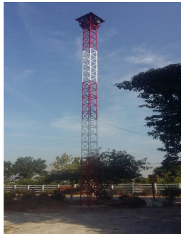
ก่อสร้างหอกระจายข่าว หมู่ที่ ๔ , ๕ , ๖
