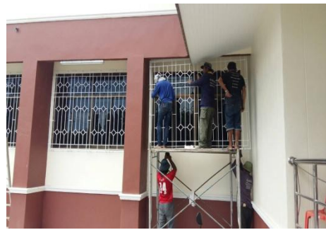
ติดเหล็กดัดประตูหน้าต่างสำนักงาน
