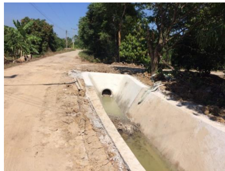
ติดตั้งคลองคอนกรีต หมู่ที่ ๑ หมู่ที่ ๒
