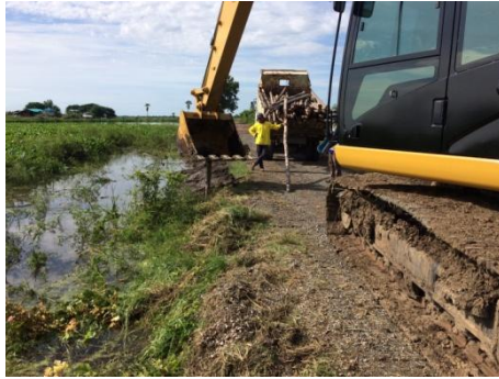
ซ่อมแซมคันบึงลาดคา หมู่ที่ ๒
