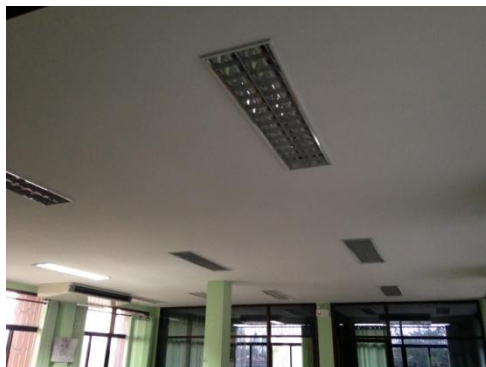
ติดตั้งไฟฟ้าสำนักงานอบต.
