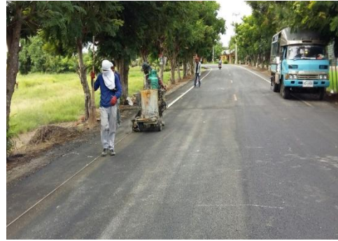
ก่อสร้างถนนลาดยาง หมู่ที่ ๓
